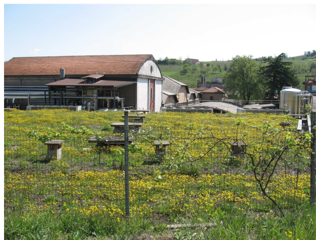
Figura 12: Vista dal punto di misura 9, presso recinzione posteriore Cantina La Versa
