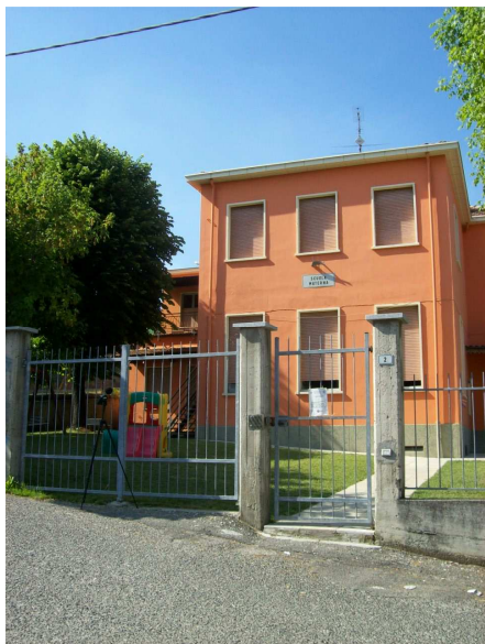
Figura 5: Vista del punto di misura 4 - Asilo Comunale in Via Garibaldi
