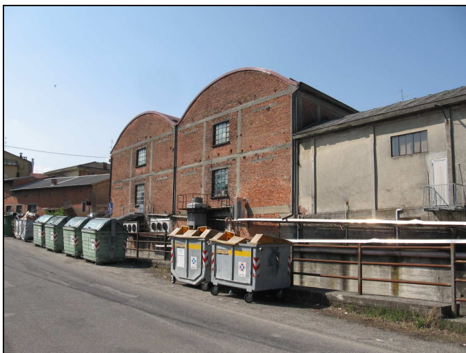
Figura 3: Vista dal punto di misura 2 - RETRO Cantina in Via Pianella
