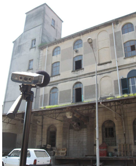
Figura 9: Vista dal punto di misura 7
