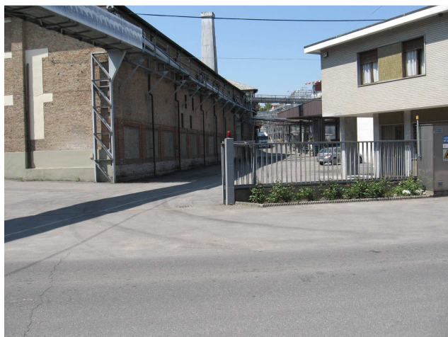
Figura 11: Vista della Cantina La Versa dal punto di misura 8
